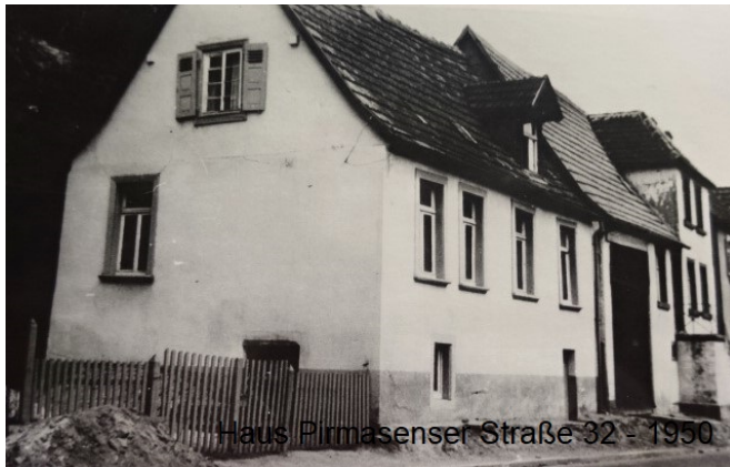
Das Haus vor dem Umbau 1950, Archiv Theo/Peter Zwick
